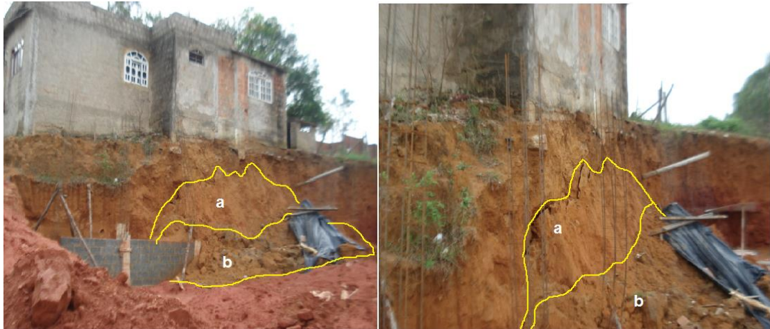
Figura 27: Escorregamento em Latossolos, Morada de Bethania, Viana (ES), novembro de 2010, em chuva diária de 94,8 mm, sem acumulado antecedente. a) deslocamento de Latossolo em área de risco (moradia) a montante e b) parte do depósito. Foto e Organização: a autora.
