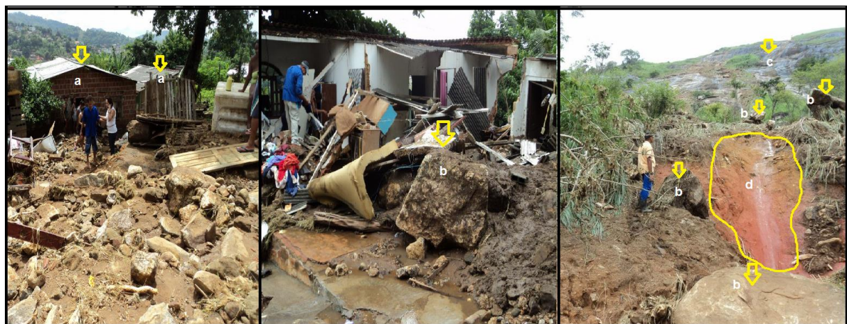
Figura 30: Escorregamento em Neossolos Litólicos e escorregamento e queda de blocos e matacão em Cambissolos, na encosta do bairro Ipanema Viana (ES), 14/11/2011, para 96,6 mm de chuva diária, 169,2 mm em acumulados de 3 dias, 394,8 mm em 7 dias. Áreas de risco: a) moradias no local dos depósitos, a jusante da vertente, b) depósitos do movimento de massa c) escorregamento em Neossolo Litólico, envolvendo o deslocamento de material inconsolidado e blocos de rocha e d) escorregamento de matacão no Cambissolo. Foto e Organização: a autora.
