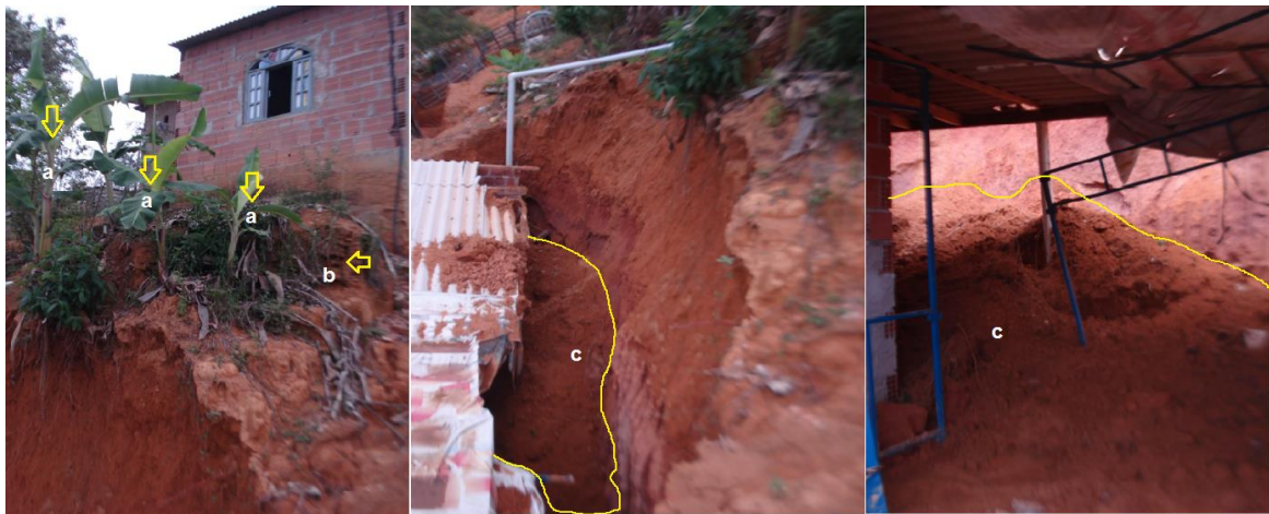
Figura 28: Escorregamento em Latossolos no bairro Vale do Sol, Viana (ES), novembro de 2010, em chuva diária de 94,8 mm, sem acumulado antecedente. a) Vegetação irregular e moradia a montante do talude. b) Contenção com material inapropriado. c) Depósito de material de terroso escorregado. Foto e Organização: a autora.
