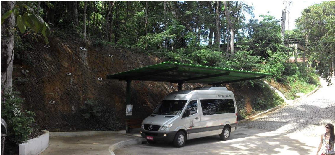
Figura 39: Encosta estabilizada com solo grampeado Fonte: Julia Frederica Effgen (junho de 2015)
