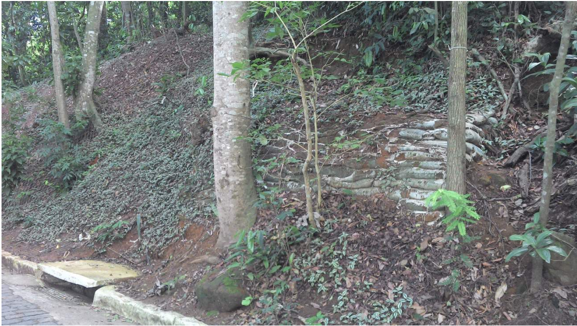
Figura 40: Encosta estabilizada com solo grampeado e sacos de areia Fonte: Julia Frederica Effgen (junho de 2015)
