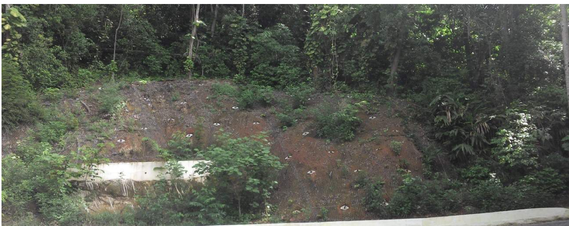
Figura 41: Encosta estabilizada com solo grampeado e muro de arrimo Fonte: Julia Frederica Effgen (junho de 2015)
