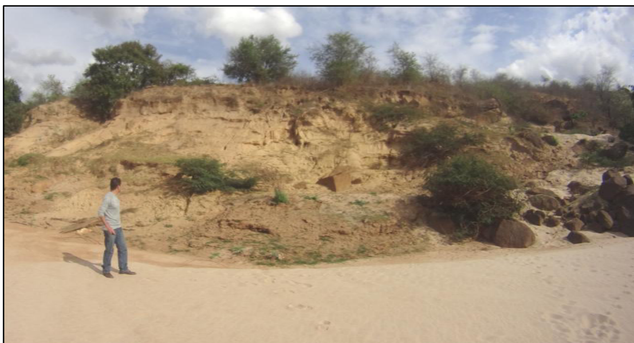
Figura 25 – Margem direita do rio Doce 900 metros à jusante da barragem da UHE de Mascarenhas evidenciando a erosão após o último período de cheia em 2017.
