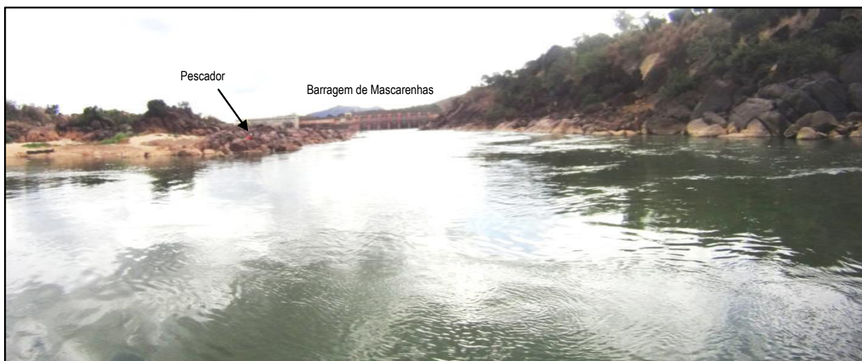
Figura 26 – Trecho entalhado do rio Doce a jusante da barragem da UHE de Mascarenhas, notando também à esquerda a erosão marginal desencadeada pelo fluxo turbulento das águas durante os períodos de cheias e/ou abertura das comportas da barragem.
