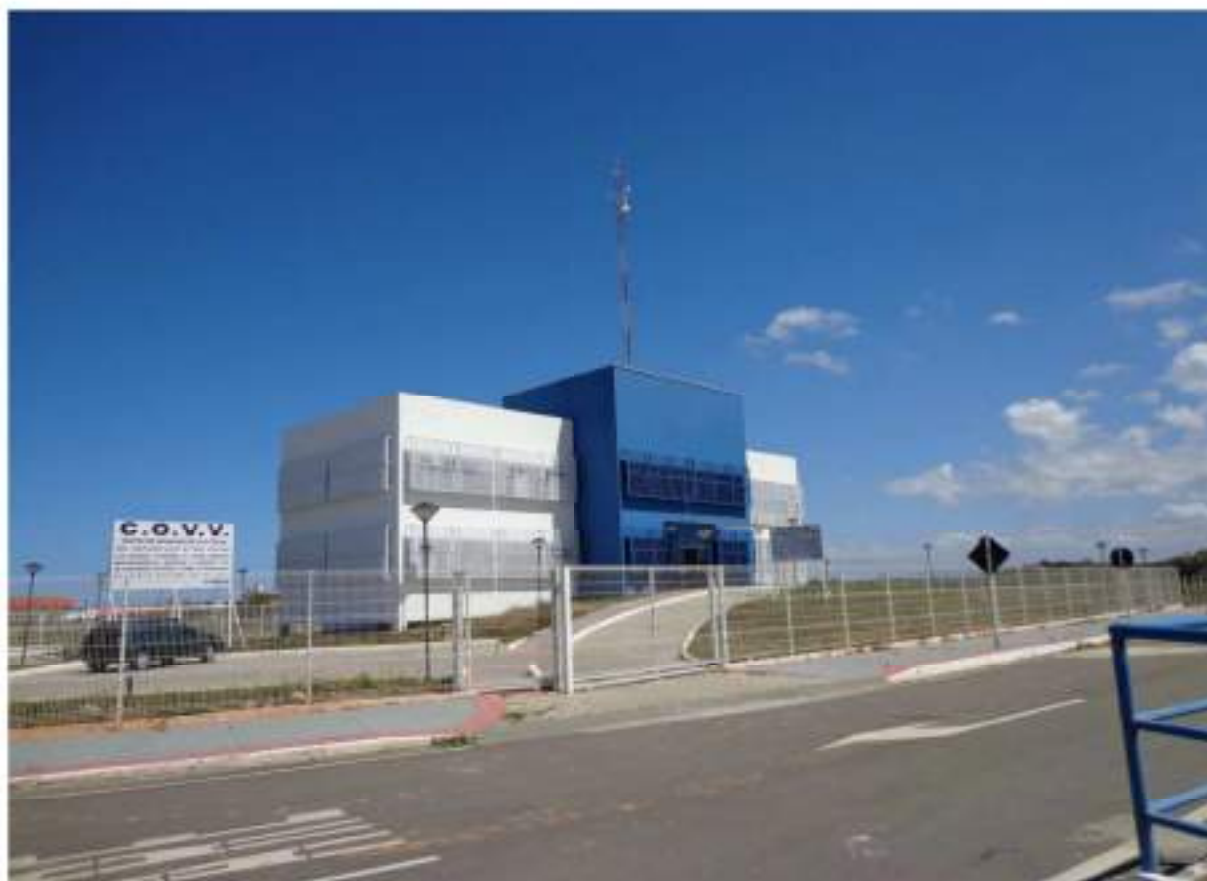
Figura 21: Estrutura Retroportuária – Centro de Operações de Vila Velha (COVV)
